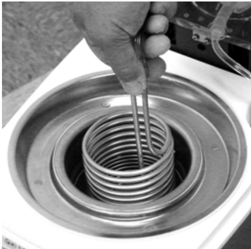
Afbeelding 4.37. De warmtewisselingsspiraal installeren
